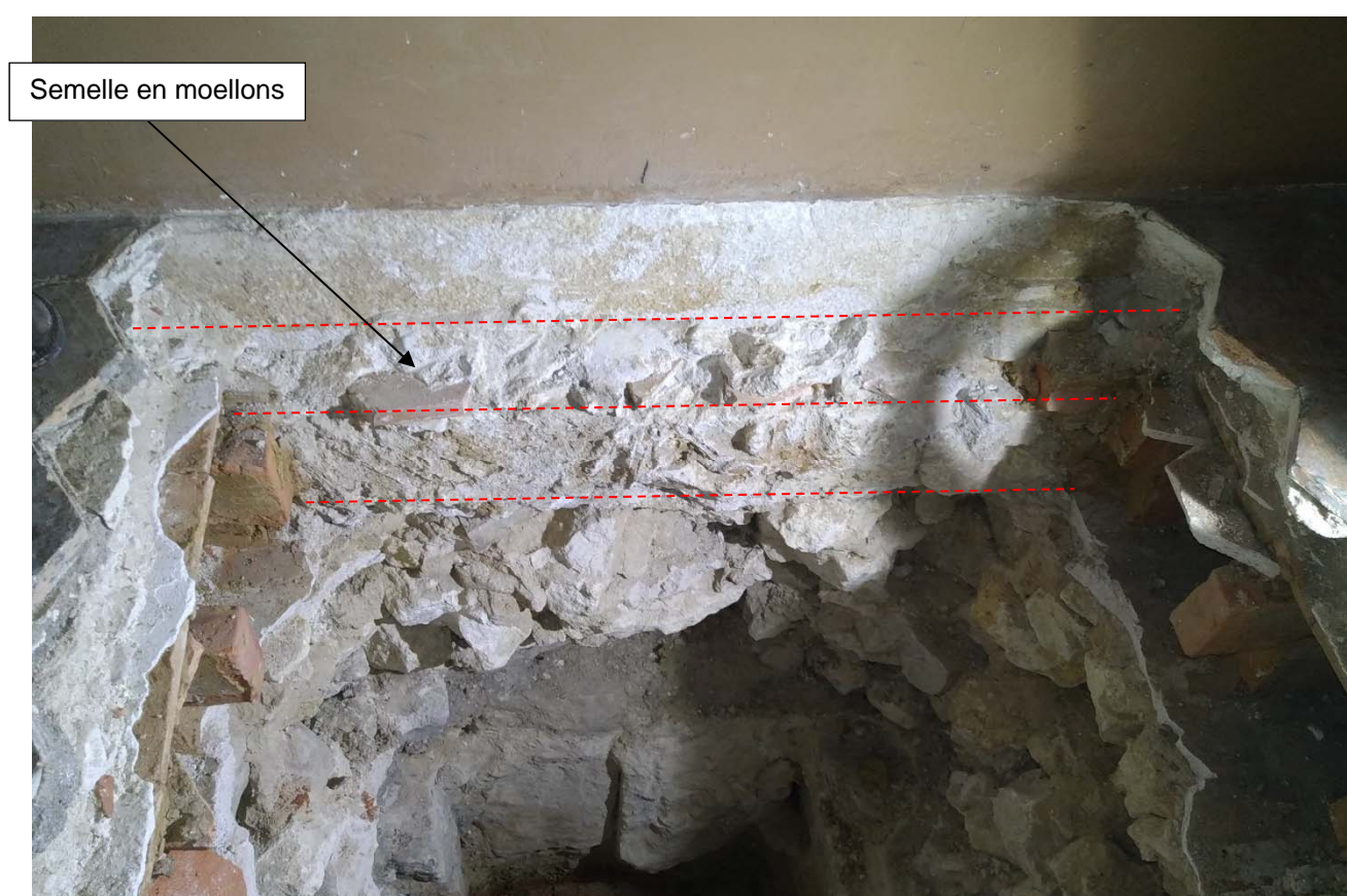
Vue de la fondation du pan de bois – fouille RFI
